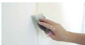
Trattamento dei giunti
