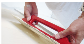
Incollaggio dei pannelli
